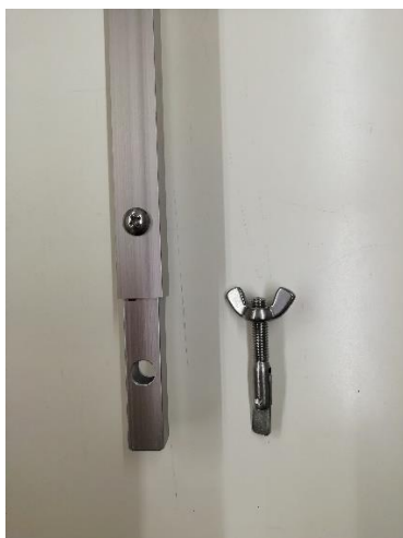
継ぎ足し部分と抜け止めピン
